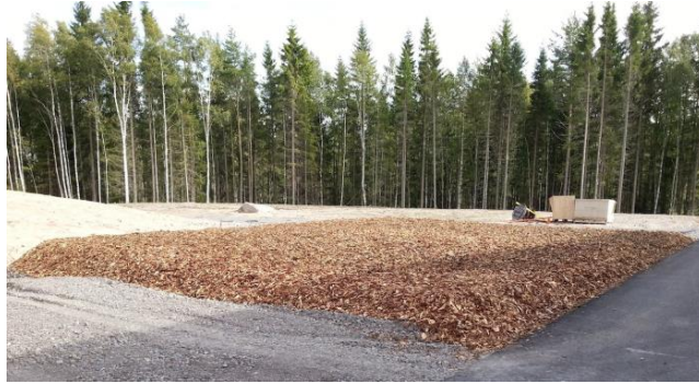
Figur 7. Exempel på ett biofilter för luktreduktion vid Biogasbolaget i Karlskoga. Foto: Biogas Öst
