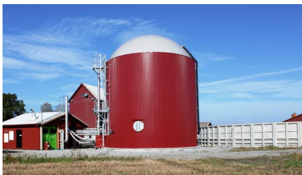
Figur 3. Exempel gårdsanläggning – Frötorps gård, Örebro – producerar biogas från svinflytgödsel och gasen används internt till el och värme. Bild: Biogas Öst
