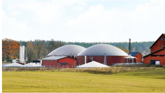
Figur 5. Exempel samverkansanläggning – Katrineholm Biogas – producerar ca 30 GWh biogas från flytgödsel, livsmedelsindustriavfall etc. och biogasen uppgraderas till fordonsgas. Samverkan mellan ca tio lokala lantbrukare och ett privat bolag. Bild: Swedish Biogas International
