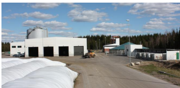
Figur 4. Exempel samröttningsanläggning – Svensk Växtkraft, Västerås – producerar drygt 20 GWh biogas från matavfall, vall etc. och biogasen uppgraderas till fordonsgas. Bild: Vafab Miljö AB
