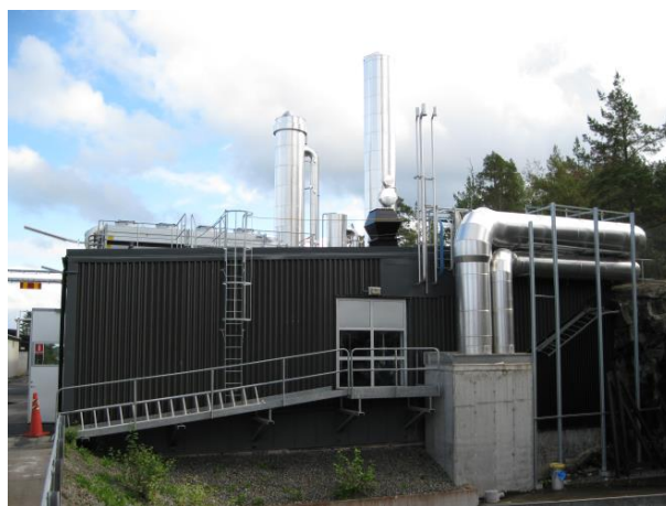
Figur 6. Exempel avloppsreningsverk med uppgradering – Käppalaverket, Lidingö Stockholm – producerar ca 40 GWh biogas från avloppsslam varav drygt 25 GWh uppgraderas till fordonsgas. Bild: Biogas Öst
